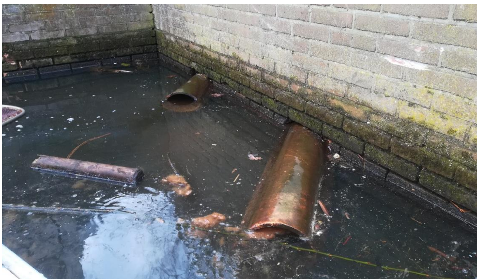
Afvoerpijp met vreemde bruine substantie aan de Kattenbroekerweg.
